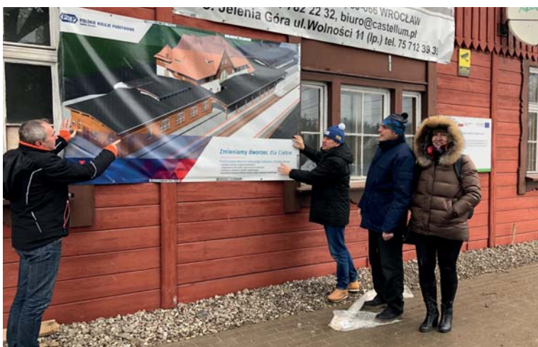
Sklářská Poreba nám také ukázala průběh rekonstrukce historického nádraží z dob Pruska. Vlevo starosta Sklářské Poreby Miroslav Grof a starosta J. Zeman. Generální rekonstrukce nádraží bude stát cca 100 mil. Kč.
