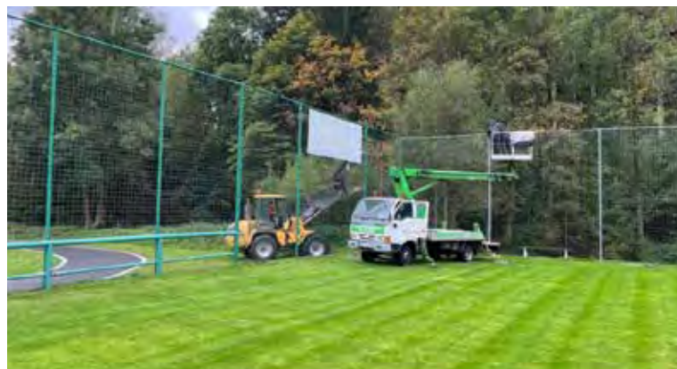
Oprava poničeného plotu na fotbalovém hřišti 1. října 2024.
