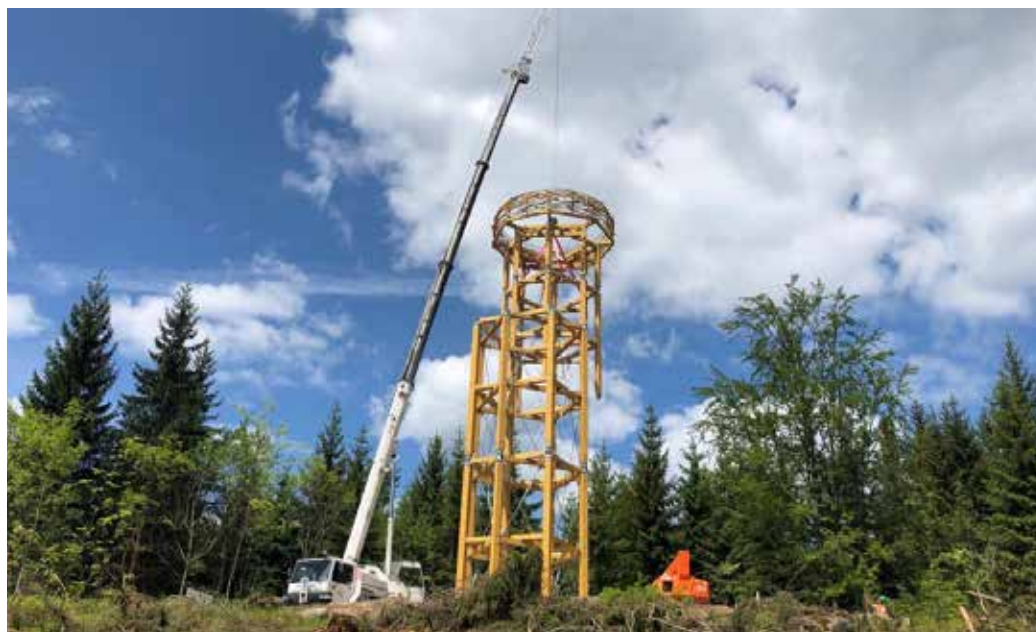
Kompletace konstrukce za pomoci speciálního jeřábu s nástavbou pana Polešovského z Desné. Foto z 15.6.2020.
