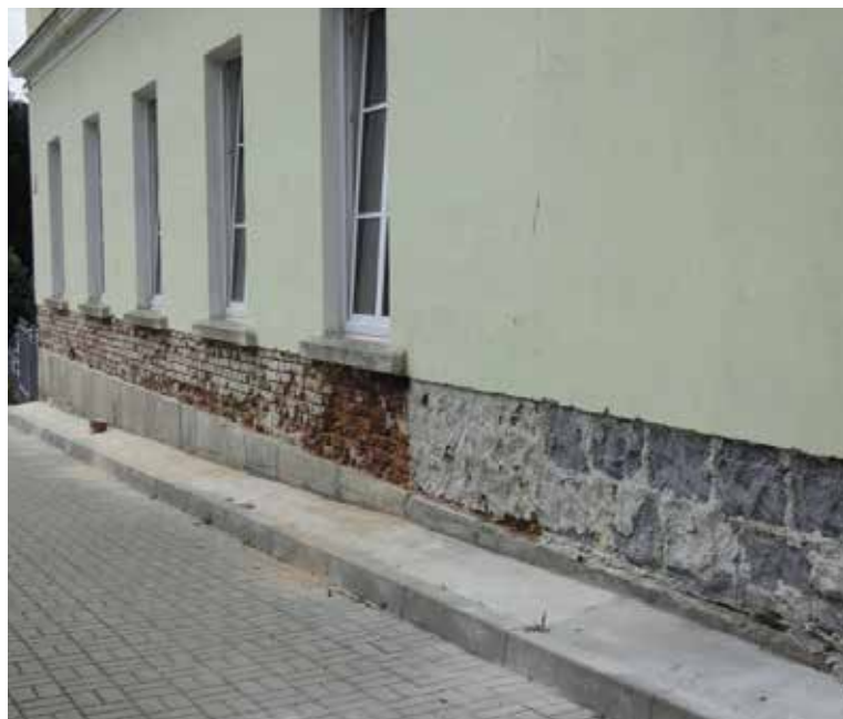
Oprava fasády. Okopaná spodní část. Odborná firma udělala injektáží vodorovnou izolaci.
