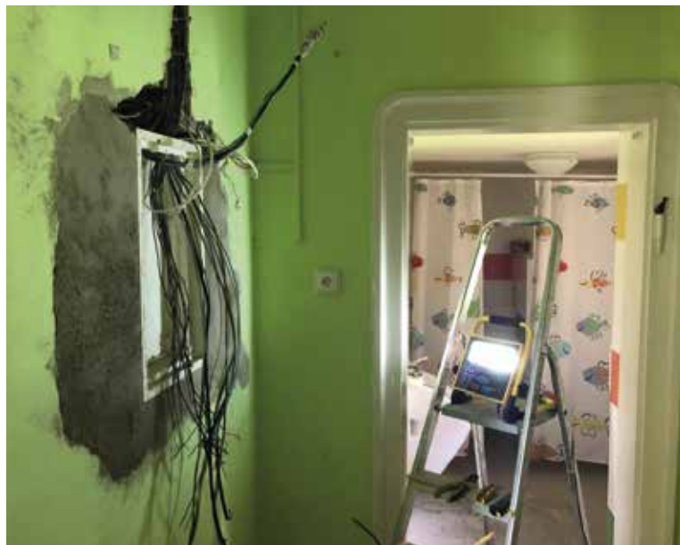
Montáž nové elektroinstalace. Stará pocházela z přelomu 60-70tých let minulého století.
