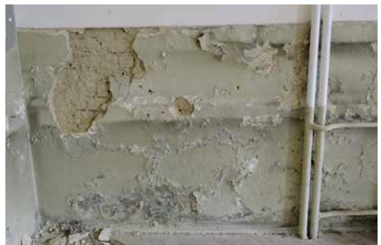
Detail vlhkých stěn v tělocvičně po sundání umakartového ostění. Zeď musela být okopána a očištěna. Následovala izolace proti vlhkosti a nahození zdí sanační omítkou.
