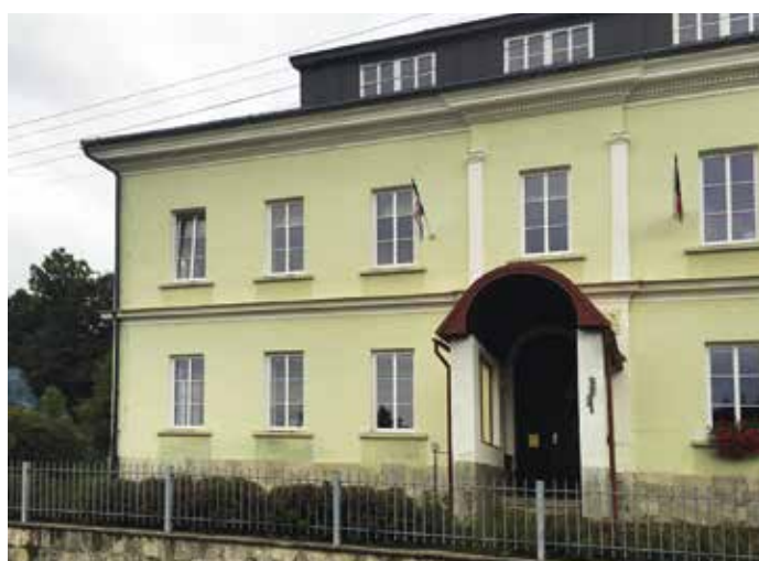
Stav v květnu 2021 před rekonstrukcí. Na fasádě chybí celá řada zdobných prvků. Zádveří z počátku 90-tých let začalo být také problematické.
