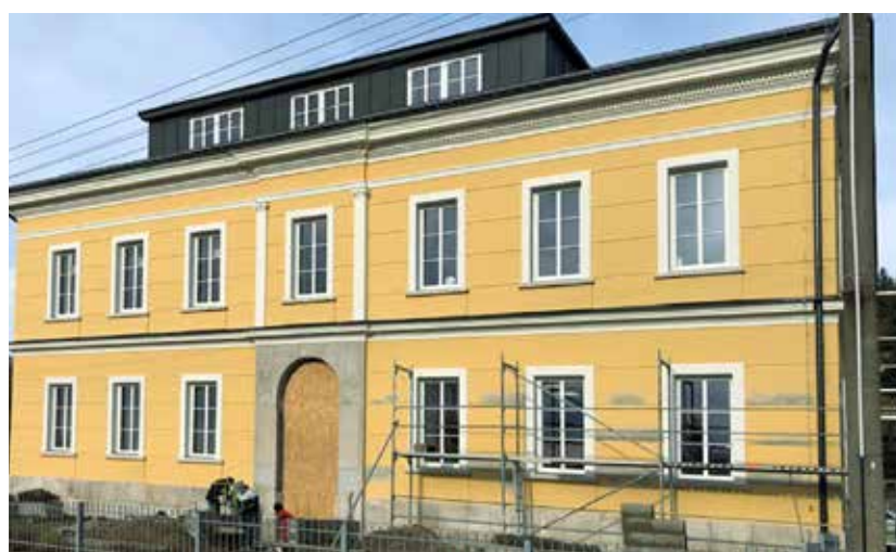
Stav fasády začátkem listopadu ještě před dokončením. Práce se musely kvůli počasí pozastavit a budou pokračovat opět na jaře 2022. Celkové náklady dosáhnou cca 4 mil. Kč.
