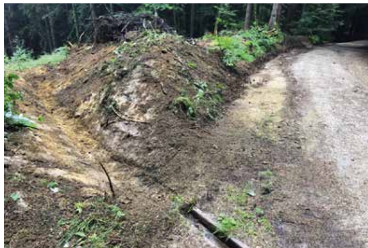
Po prudkých deštích jsme museli v srpnu opravit perkovou cestu na Světlý vrch. Opravily se svodnice a strhla se hrana cesty, která nedovolila odtok dešťové vody a ta při deštích vymlela hluboké rýhy. Opravy stály cca 80 tis. Kč.
