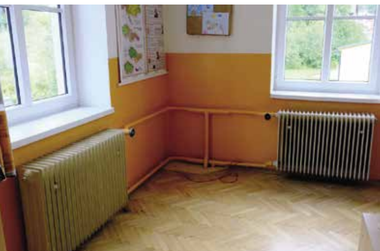
Staré topení ve třídách bylo také nahrazeno. Na fotografii stav před demontáží. Náklady na opravu topení v tělocvičně a ve třídách dosáhly 130 tis. Kč.
