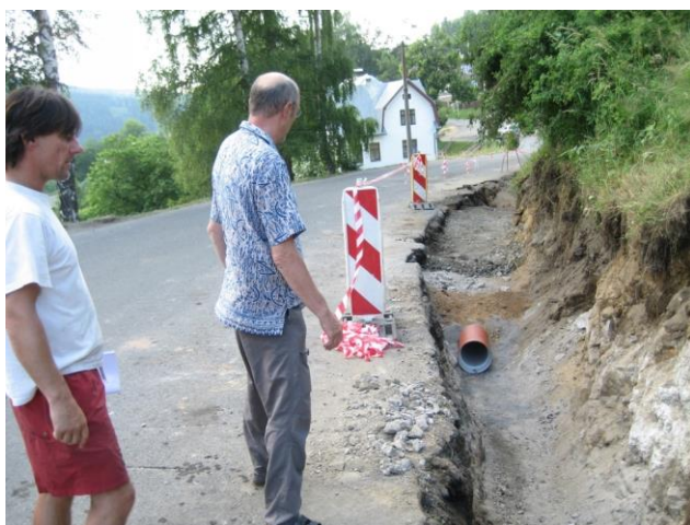
Léto 2010 odvodnění křižovatky u pomníku začalo již u Hübnerů, další odvodnění bylo zbudováno nad pensionem Lucie. Nově opraven byl i propustek od pomníku směrem k potoku. Celá křižovatka dostane i nový asfaltový povrch. Celkové náklady dosáhnou 2.500.000 Kč.
