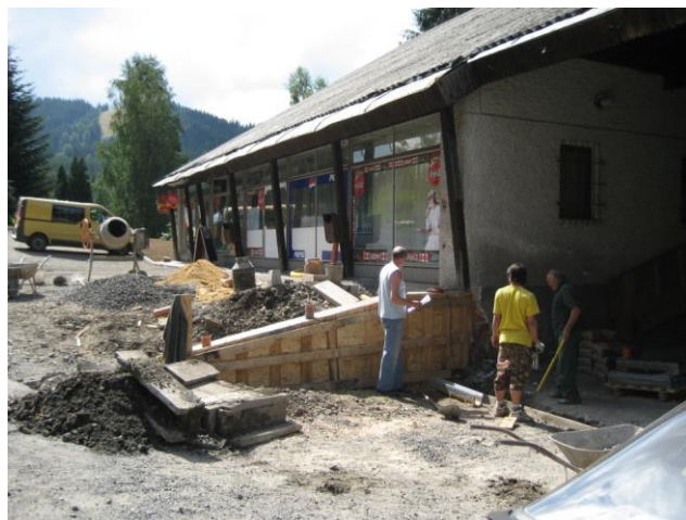
V rámci rekonstrukce hlavní silnice jsme opravili i prашné parkoviště u obchodu s potravinami. V roce 2010 jsme dokončili úpravy parku nad parkovištěm.
