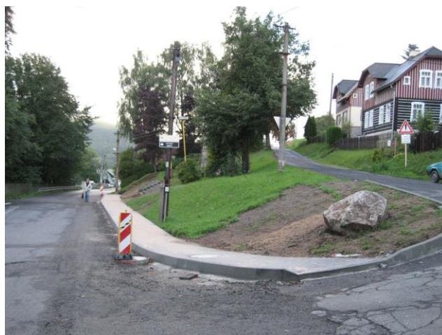
Po odvodnění křižovatky započaly úpravy okolí pomníku. Zcela nově bude postavena autobusová zastávka, která bude vhodně začleněna do prostoru u pomníku. Renovací projde i samotný pomník obětem I. a II. světové války.
