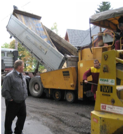
Pokládka nového asfaltu na Mariánské Hoře firmou Stavby silnic a železnic - SSŽ. Financováno z fondu SZIF. Rok 2008.
