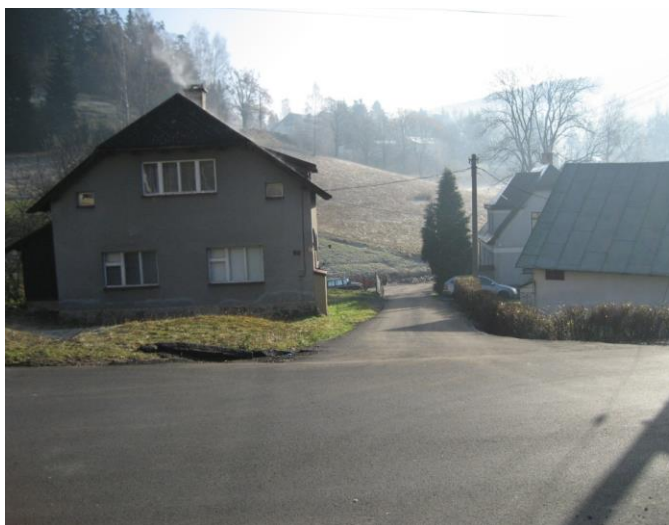
Rok 2009. V rámci oprav byl odvodněn sjezd ze „Zlaté uličky“ na hlavní silnici a podobně byla opravena cesta u Chlumů (odvodnění a nový asfalt). Celkové náklady na opravu těchto místních komunikací dosáhly 500.000 Kč.
