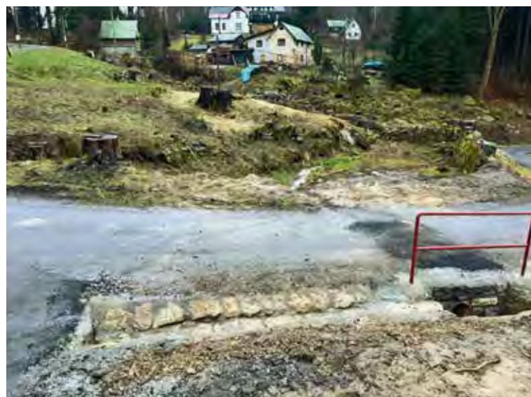
Oprava propadlého propustku na začátku Waberlochu (od Mariánské Hory). Březen 2024.
