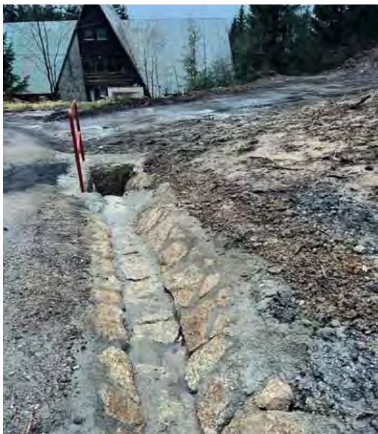
Oprava propadlého propustku na začátku Waberlochu (od Mariánské Hory). Březen 2024.
