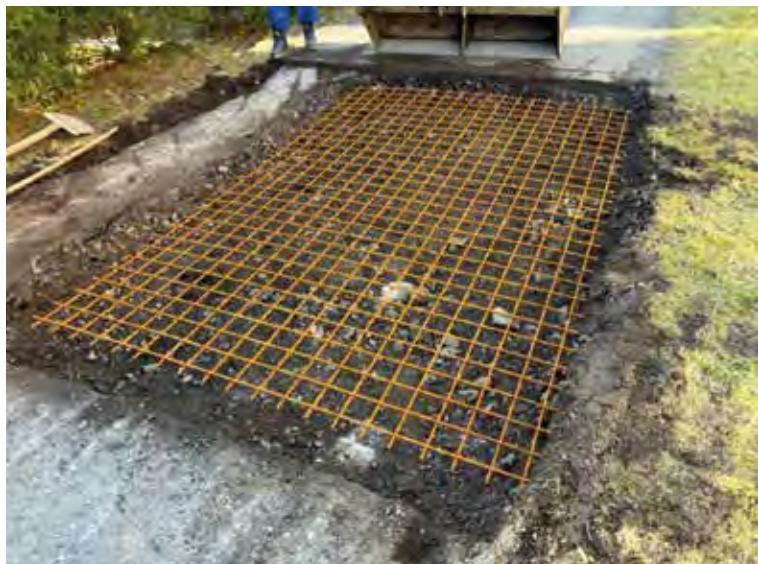
Oprava propadlého propustku na začátku Waberlochu (od Mariánské Hory). Březen 2024.
